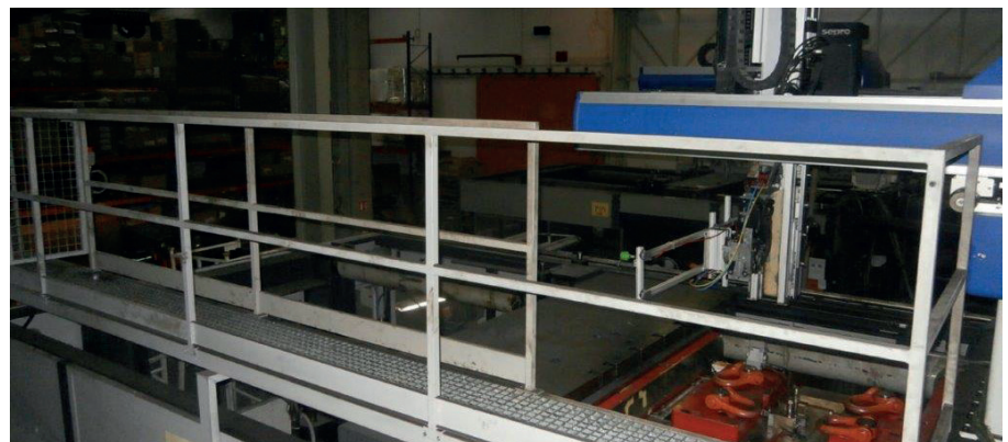
Passerelle d'accès pour intervention sécurisée
