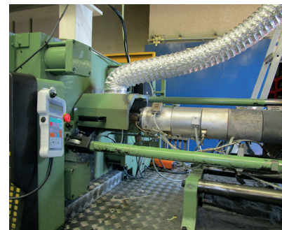
Dispositif de ventilation sur presse
