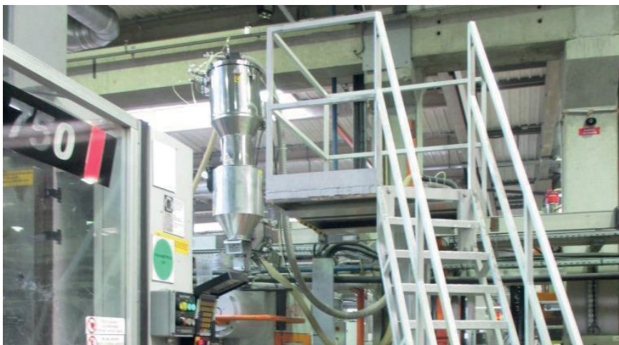
Accès sécurisé au colorateur (escalier, plateforme)
