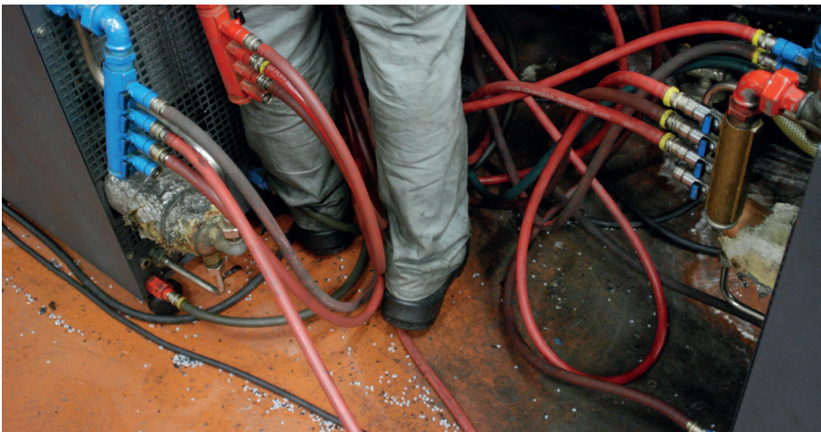
Câbles, granulés au sol
